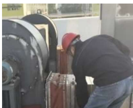
▲热压成型废气处理设施的排风扇、风机老化，更换新设备
