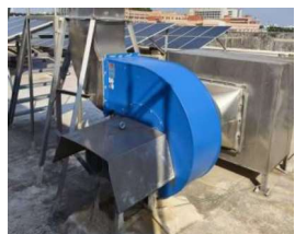
▲热压成型废气处理设施的排风扇、风机老化，更换新设备
