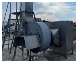
▲热压成型废气处理设施的排风扇、风机老化，更换新设备
