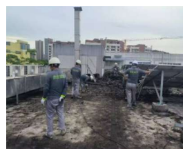
▲三期厂房楼顶地面污垢清除、铺设防水隔热层，降低室内温度，节省能源消耗
