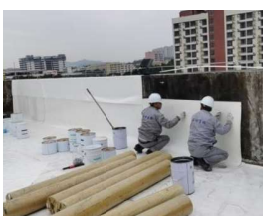
▲三期厂房楼顶地面污垢清除、铺设防水隔热层，降低室内温度，节省能源消耗
