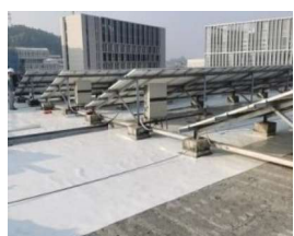
▲三期厂房楼顶地面污垢清除、铺设防水隔热层，降低室内温度，节省能源消耗
