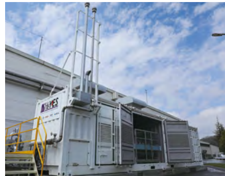
水素製造装置（やまなしモデルP2Gシステム）
