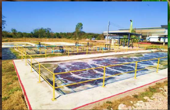
ระบบบำบัดน้ำเสียชีวภาพ2
