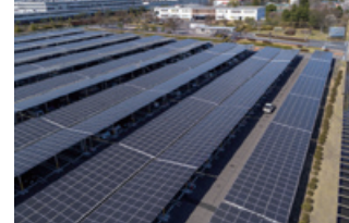
従業員駐車場の太陽光発電パネル
