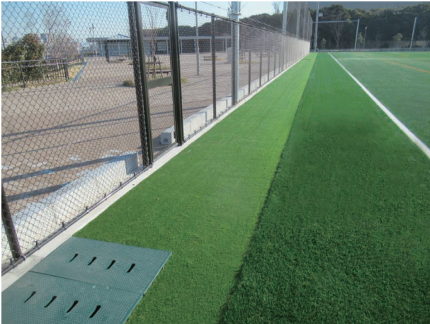
雨水溝上にフィルター材として透水性人工芝を設置するとともに外周をブロックで囲うことで風による飛散を抑制
