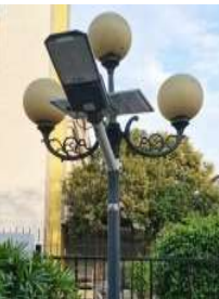
▲ 路灯追加光伏板
