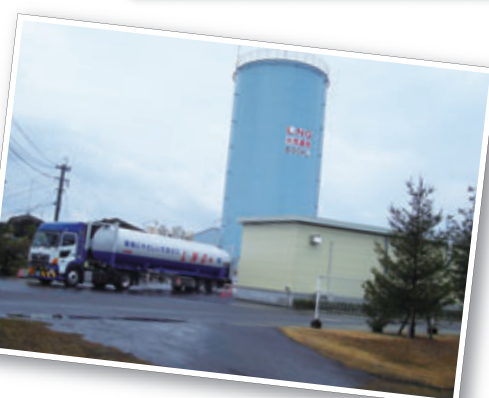
LNG satellite at the Miyazaki Factory
